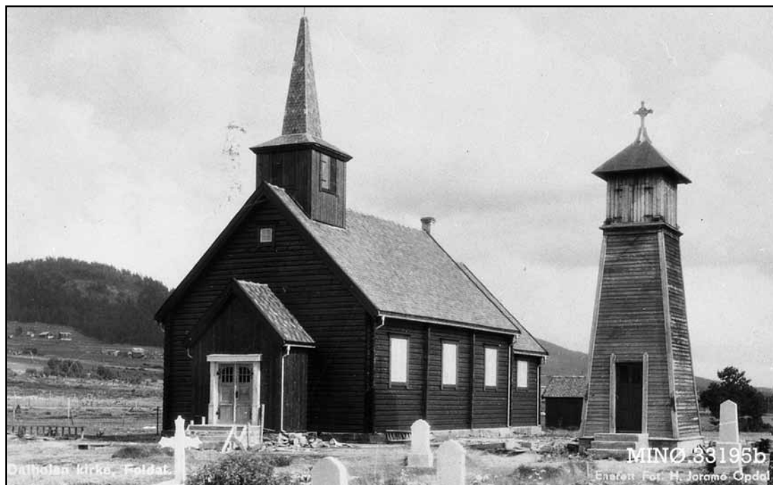
Dalen kapell , fotografert mens støpulen fortsatt står. Foto: H. Joramo, Oppdal / Musea i Nord-Østerdalen, nr. 33195B
