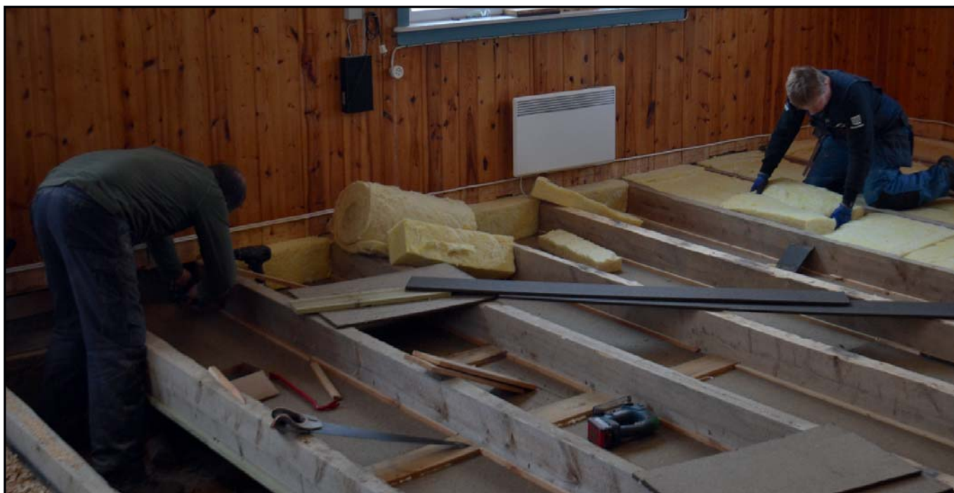
Gulvet er revet opp og det blir lagt ny isolasjon. Kyrkjjetjener Bård Høisen Lohn (t.v.) og håndverker Frode Solly i arbeid.
